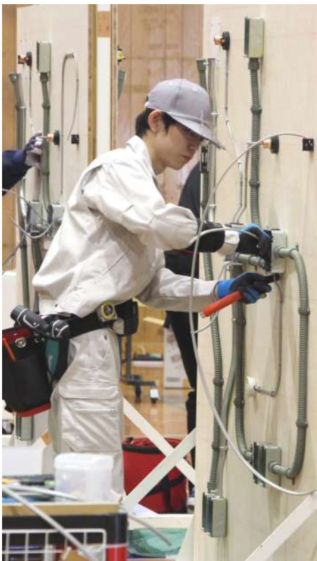
ケーブルをアウトレットボックスに通す荻原君
